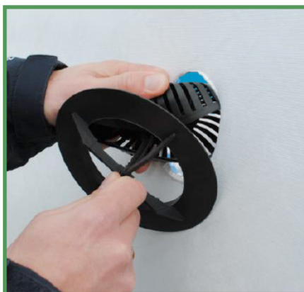
Pres entilstudsens sammen, så undertaget er placeret mellem dæksel og underdel.
