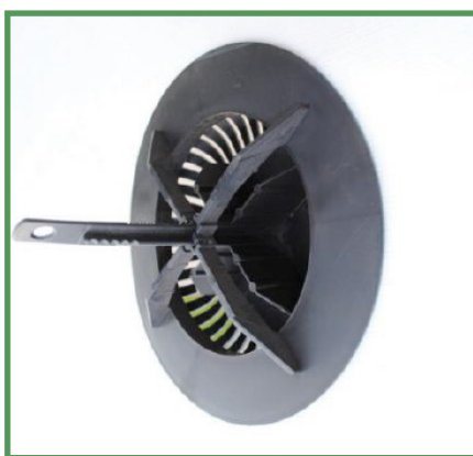
Ventilstudsens er nu monteret - set indefra.
